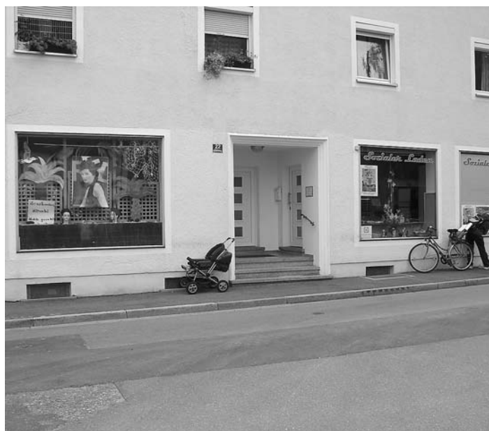
Hinter dem linken Schaufenster entsteht die Ladenerweiterung
